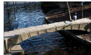
Un pont en béton armé est un pont dont un des éléments de la structure porteuse (tablier, arc ou poutre) est en béton armé. Le pont du Jardin des plantes de Grenoble, premier ouvrage au monde en béton coulé, construit en 1855 par Louis Joseph Vicat
