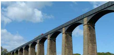
Le pont-canal de Pontcysyllte est un pont-canal imaginé et construit par les ingénieurs Thomas Telford et William Jessop. Il porte le canal de Llangollen (en) au-dessus de la rivière Dee, au Pays de Galles. Il a été ouvert en 1805. Il est en fonte.
