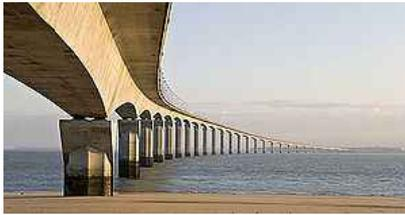
Un pont en béton précontraint est un pont dont la structure porteuse (arc ou poutre), est en béton précontraint. Pont de l'île de Ré, constitué de 796 voussoirs précontraints préfabriqués à terre, puis assemblés par encorbellement
