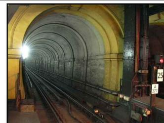
Le Tunnel sous la Tamise est un tunnel sous-marin passant sous la Tamise, à Londres. Il est large d'environ 11 mètres, haut d'environ 6 mètres et long d'environ 396 mètres. Construit entre 1825 et 1843.
